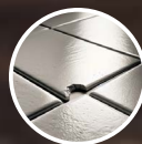
сколы на плитке
